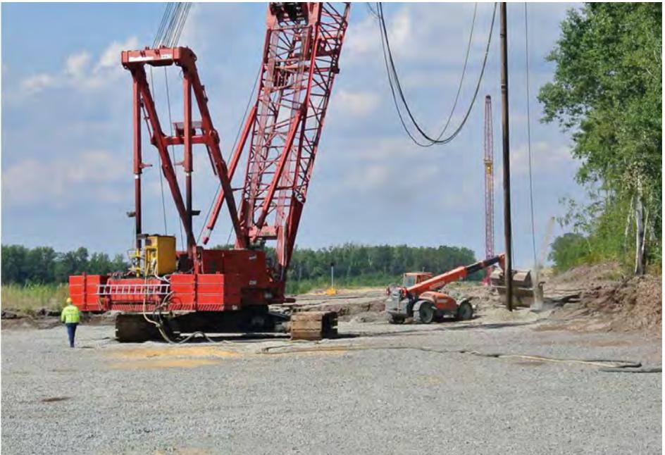
Abb. 5: Befüllen des Schüttkübels der Rüttellanze bei der Rüttelstopfverdichtung
