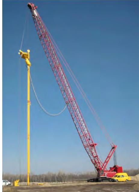
**Abb. 3:** Trägergerät mit Rüttellanze der Rüttelstopfverdichtung Foto: DB ProjektBau GmbH
