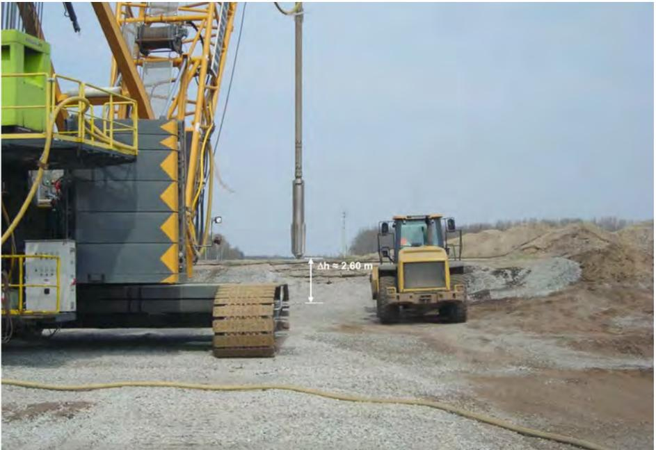
Abb. 9: Geländeabsenkung durch die Rütteldruckverdichtung im Bereich der Innenkippe Lohsa
